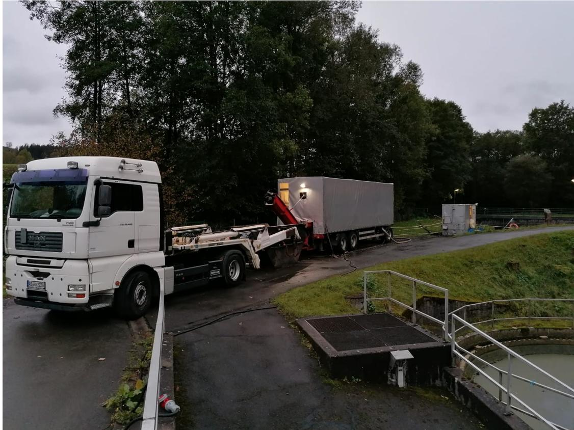
Im Oktober wurden auf der Kläranlage Stammbach durch eine Spezialfirma insgesamt 1962 m<sup>3</sup> Klärschlamm gepresst.
