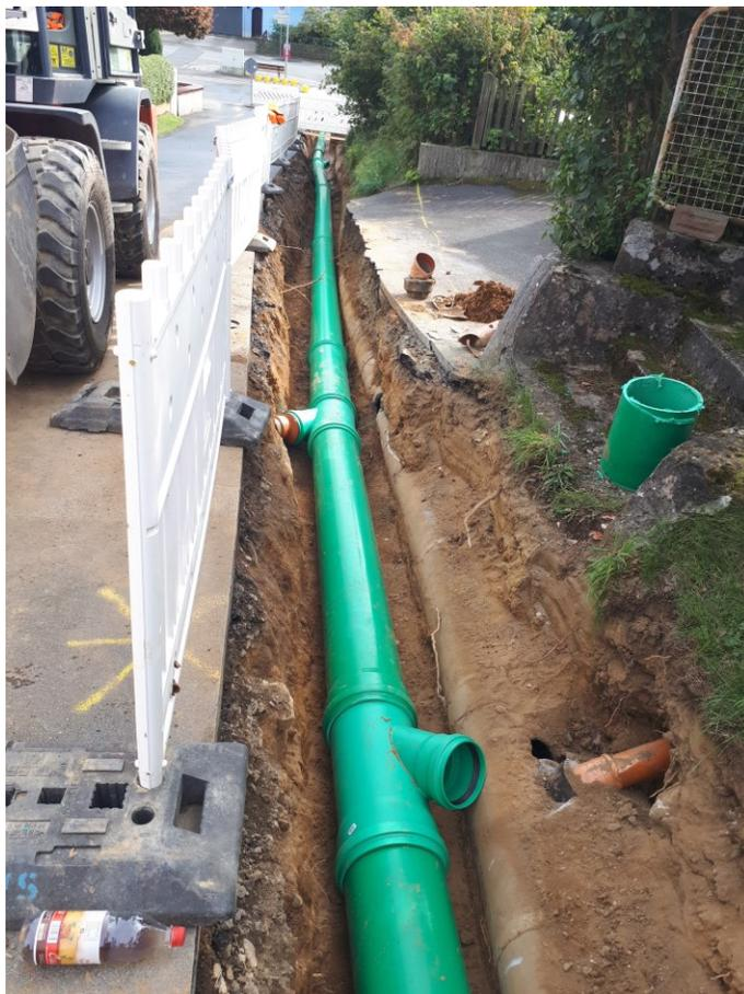
Neben einer Vielzahl von Unterhaltsmaßnahmen im Kanalnetz wurde im Bereich Siedlung ein neuer Mischwasserkanal verlegt und die bestehenden Hausanschlüsse wieder angebunden.
