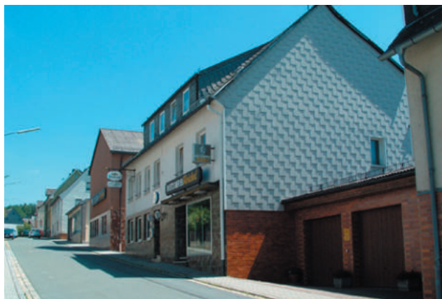
leerstehendes Wohn- und Geschäftshaus (Kulmbacher Straße)
