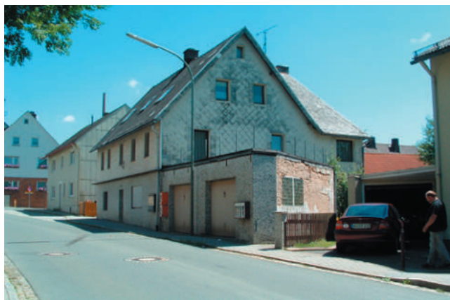
leerstehendes Gebäude in der Kulmbacher Straße
