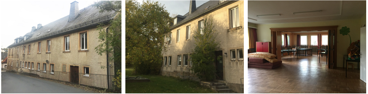
Foto-Aufnahmen Gemeindehaus und Umfeld
