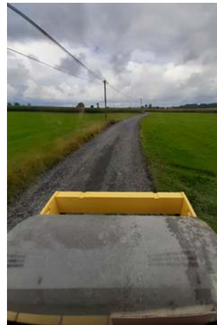
Wegebau Fleisnitz nach Altpoppenreuth mit Fräsgut
