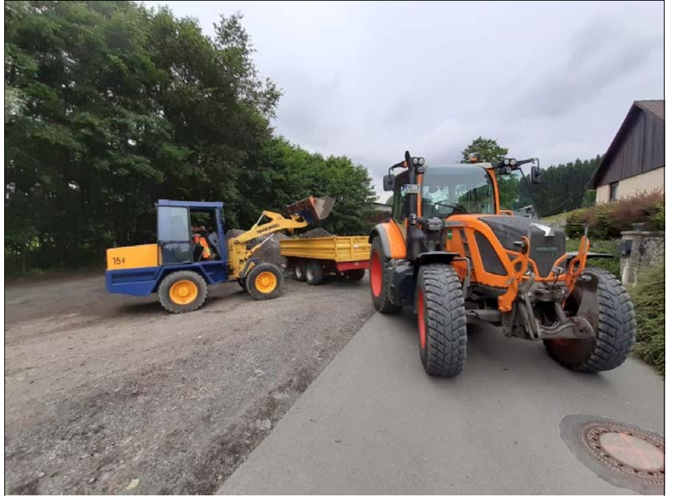
Wegebau Fleisnitz nach Altpoppenreuth mit Fräsgut
