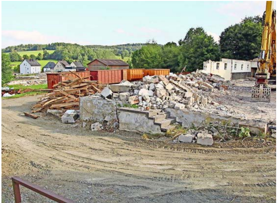
Ein neues Wohngebiet „Sonnenleite“ entsteht auf dem ehemaligen Betriebsgelände der Firma Bergophor. Die Firmengebäude werden derzeit bereits abgerissen. Foto: Klaus Klaschka
