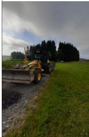
Wegebau Fleisnitz nach Altpoppenreuth mit Fräsgut
