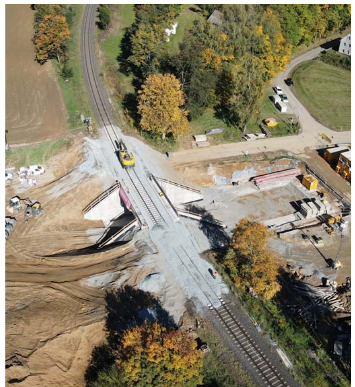
Die neue Brücke fertig verfüllt und bereits mit verlegten Schienen.
