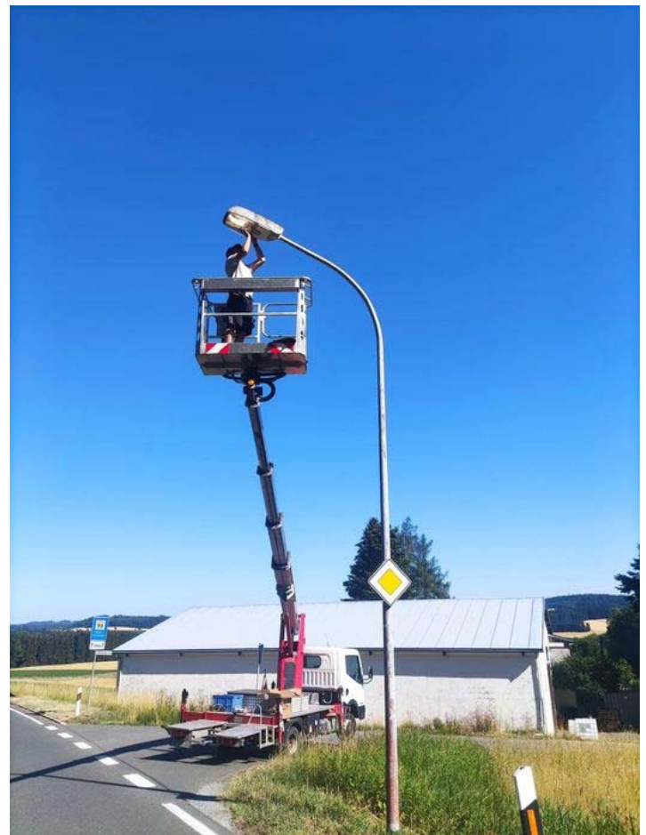
Die Mitarbeiter der Gemeindegewerke Stambach beim Wechseln der Beleuchtung.
