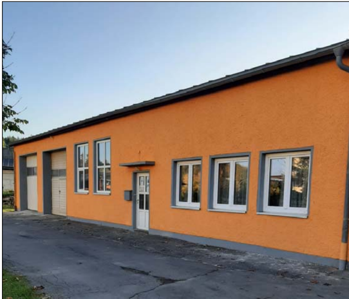
Die in Eigenregie durchgeführte Fassadensanierung an der Fahrzeughalle im Bauhof ist nun abgeschlossen. Die Halle strahlt nun wieder in einen freundlichen Orange.
