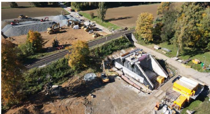
Die neue Brücke wurde direkt neben der Strecke aufgebaut.
