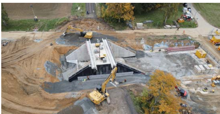
Die neue Brücke bei Tageslicht an Ort und Stelle.
