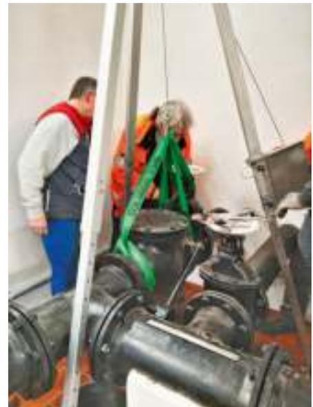
Das Foto links zeigt die neue Rückschlagklappe mit dem neuen Schieber, das rechte Foto zeigt die alte Rückschlagklappe mit dem alten Schieber vor dem nächtlichen Ausbau.
