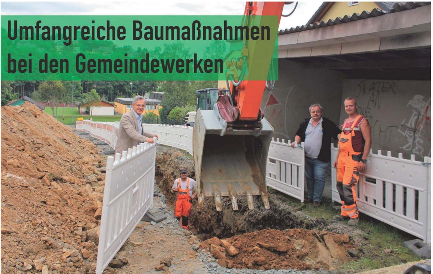
Auf 360 Metern verlegen die Gemeindewerke Stambach mit den Geschäftsbereichen Trinkwasser- und Elektroversorgung zwischen der Mühlstraße und der Station Landscheidbühl ein 20kV-Mittelspannungskabel und neue Wasserleitungsrohre.
