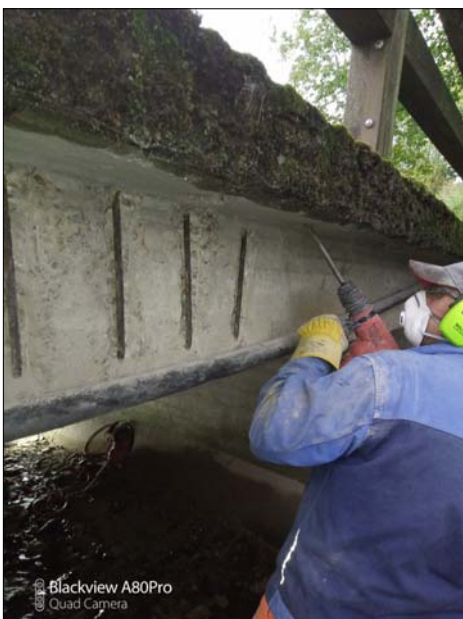
Die Brücke an der Kläranlage wird aktuell saniert - auf den Bildern legt ein Arbeiter der beauftragten Fachfirma Schadstellen mit schwerem Gerät frei - der Bauhof unterstützt die Maßnahme begleitend
