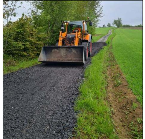
Fräsgut Einbau Förstenreuth Richtung Hochbehälter Karlsberggruppe. Verwendet wurde das angefallene Material der Straßensanierung der B289.
