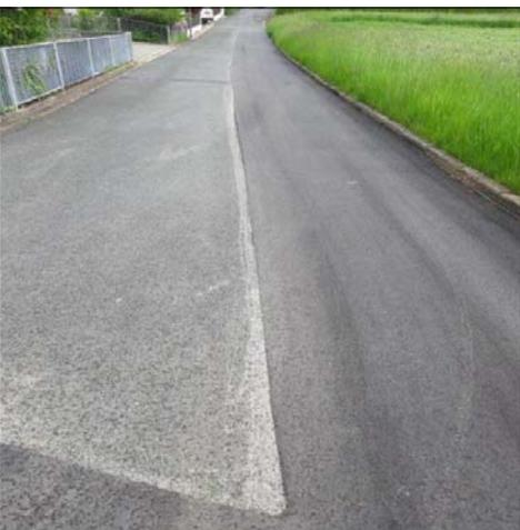
Bei den Ausbaurbeiten der Gasleitung Löhleinweg/ Jahnstraße wurden im Bereich Löhleinweg tiefe Fahrspuren der Fahrbahn ausgeglichen und neu asphaltiert.
