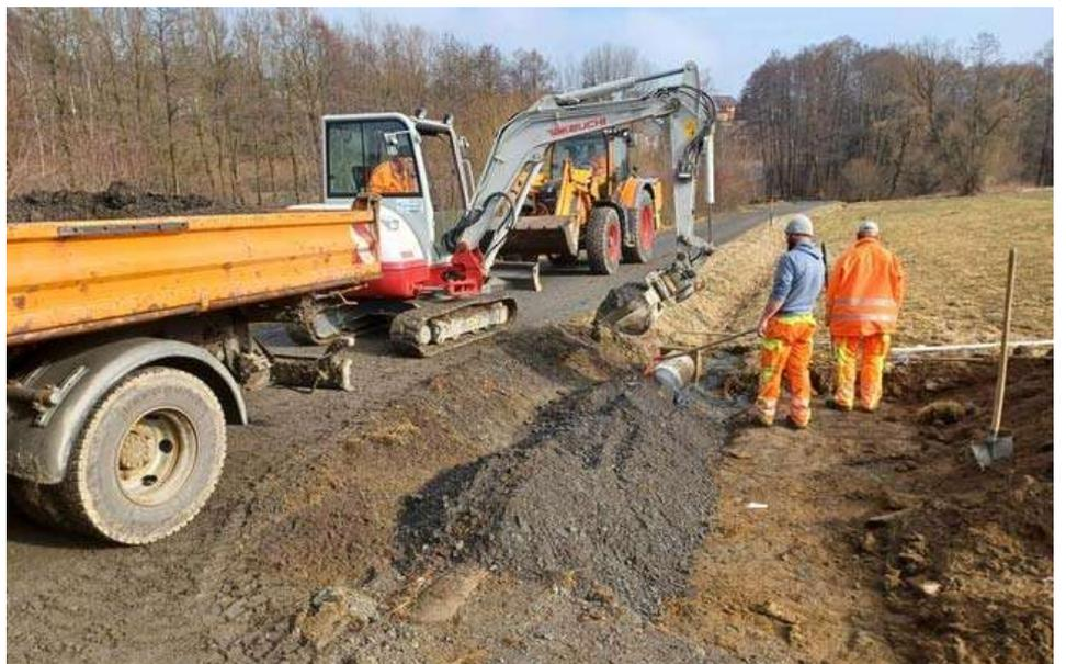
*Im Beerenleitenweg gegenüber der Kläranlage wurde der Graben neu verrohrt. Wegen der Brückensanierung wird ein Wendepunkt für die Müllabfuhr benötigt.*
