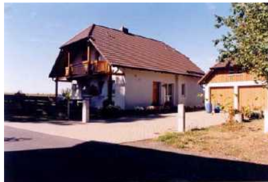
Der Balkon ist abgestützt und zusätzlich mit der Dachkonstruktion verbunden. Die Umwehrgung ist zurückhaltend gestaltet.
