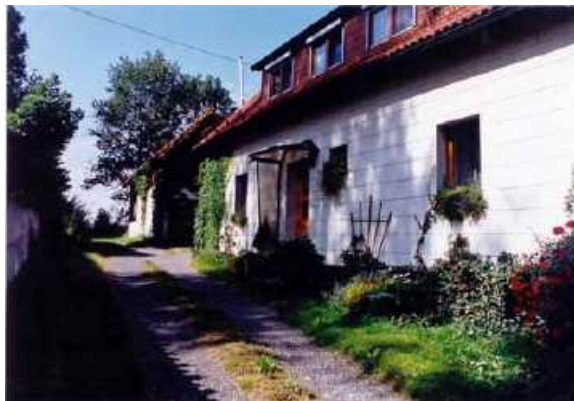
Bei diesen Anwesen mit dörflichen Charakter wirkt das Vordach aus Aluminium untypisch und stört zu dem die Harmonie der Fassade .
