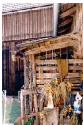
Nebengebäude in Fleisnitz
