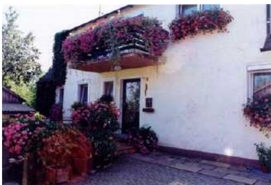
Schlicht und leicht zerbrechlich wirkend ohne Unterstützung überdeckt der Balkon den Eingang.
