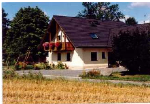
Von der Dachkonstruktion abgehängt, ist der Balkon an der Giebelfassade einfach und unaufdringlich gestaltet.
