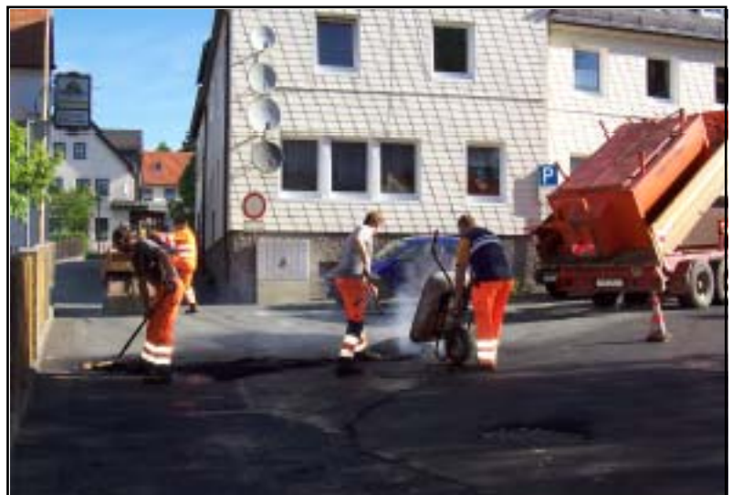
Arbeiten im Bereich der Töpferstraße.
