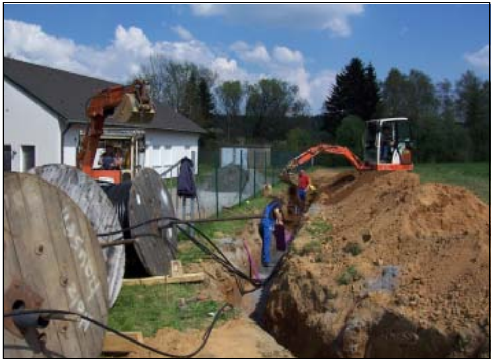
Das Foto zeigt die Bauarbeiten im Bereich des Wasserwerkes Wildenhof.
