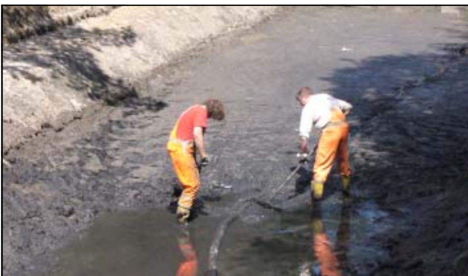
Firma Böhme beim Entsorgen des Klärschlammes.
