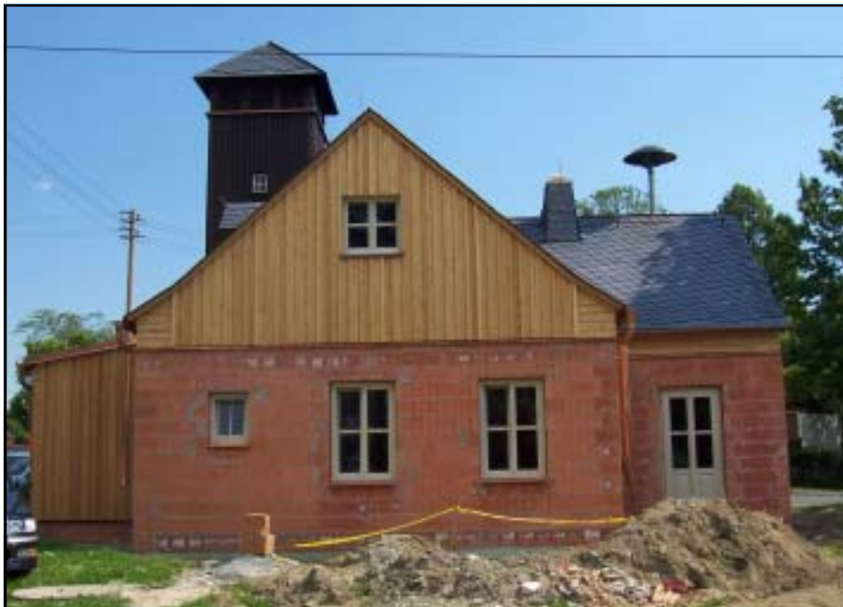
Es geht voran am Dorfgemeinschaftshaus in Fleisnitz. Im Herbst des letzten Jahres konnte man bereits Richtfest feiern.
