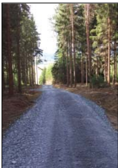
Neuer Waldweg am Karlsberg während der Bauarbeiten.
