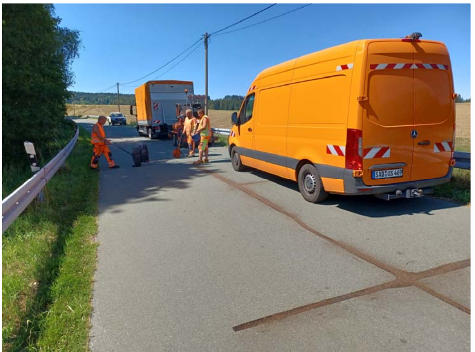
Die Arbeiten der Rissanerung sind in vollem Gange.
