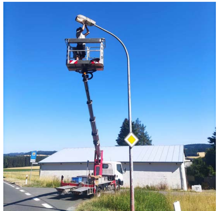
Austausch der Straßenbeleuchtung auf energiesparende LEDs
