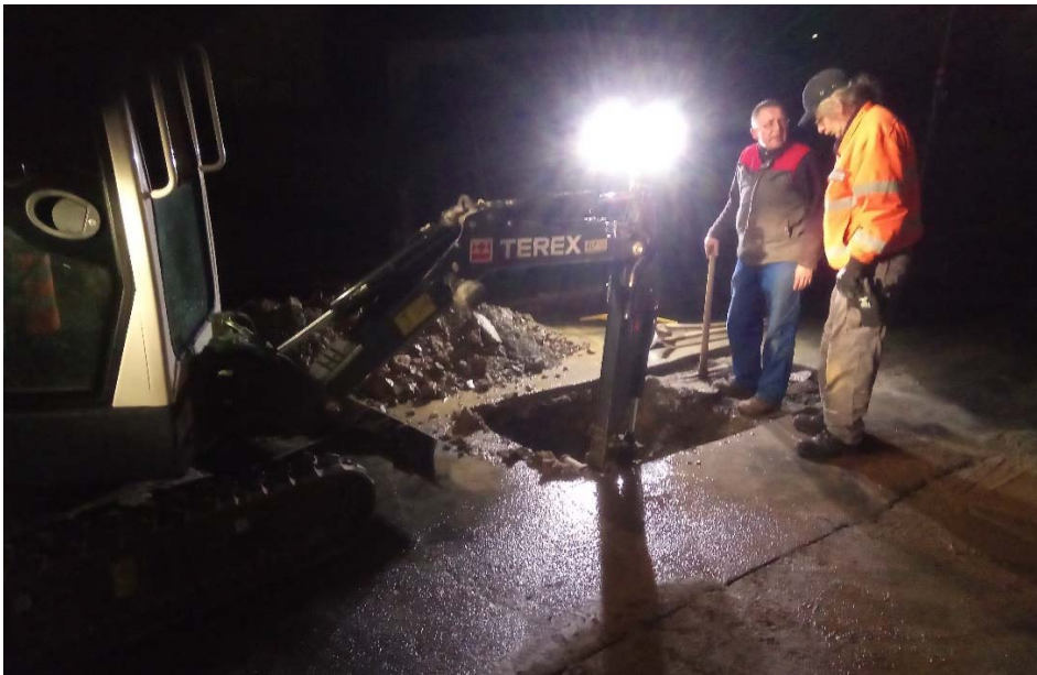
Erschwerte Arbeitsbedingungen um 3:00 Uhr früh – dennoch wurde der Rohrbruch in der Friedhofstraße bis zum Morgen repariert
