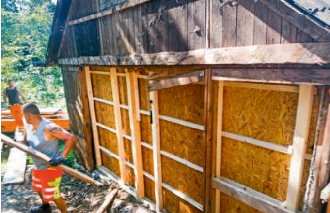
Waldhütte am Weißenstein: Innenwände und Decken wurden mit OSB neu verkleidet; die Außenverkleidung wurde mit Lärchenbrettern realisiert und neue Kunststoffenster eingesetzt. Das Dach wurde mit Kanthölzern ausgeglichen und mit Trapezblech gedeckt. Besonderer Dank geht hier auch an die Firma Therma aus Bad Steben für die Spende der Fenster und an die Firma Bonenberger aus Marktschorgast für das Schneiden der Lärchenbretter als Spende.
