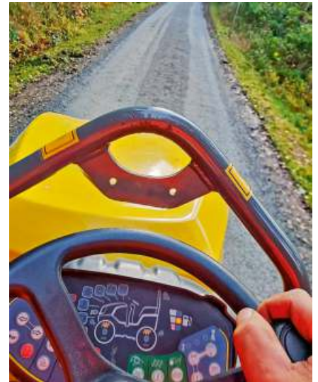
Wassergebundene Wege: Auf den Verbindungswegen HO35 zur Bergmannseinzeln und Rindlas Richtung Weißenstein wurde ein 0/8 Splitgemisch aufgezogen und mit einer Walze verdichtet.
